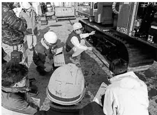
クローラーの点検箇所について説明
