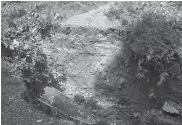
古田林道起点から0.9km地点
