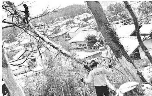
真下に民家があるため非常に危険な状況
