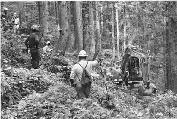
森林作業道作設技術者養成研修の状況
