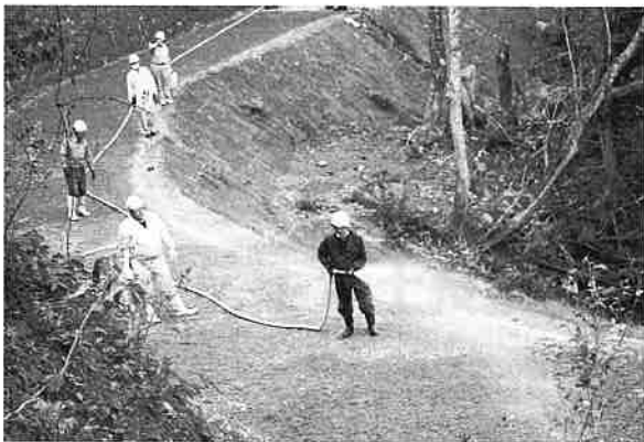
敷き均し後の散水
