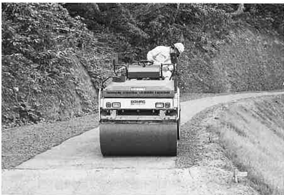
ローラーによる転圧
