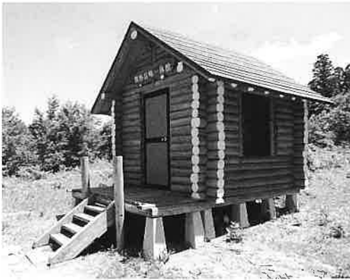
完成した熊野長峰一休館
