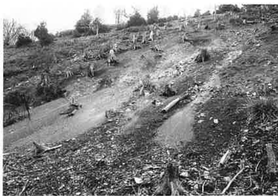
写真 シカの食害により裸地化した法面(宮城県牡鹿半島)
