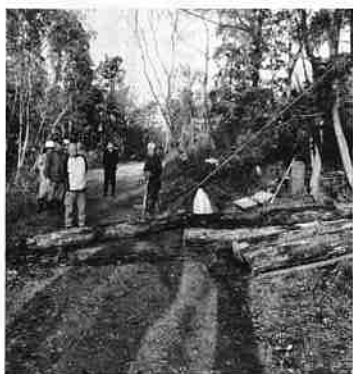
ポータブルウィンチによる 枯損木の搬出
