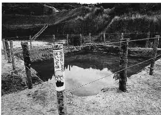
林地開発において必要な施設の一例 (水害を防ぐための調節池)
