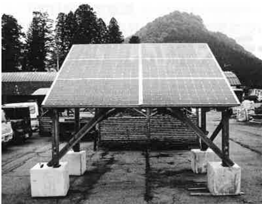
完成した太陽光発電木製架台
