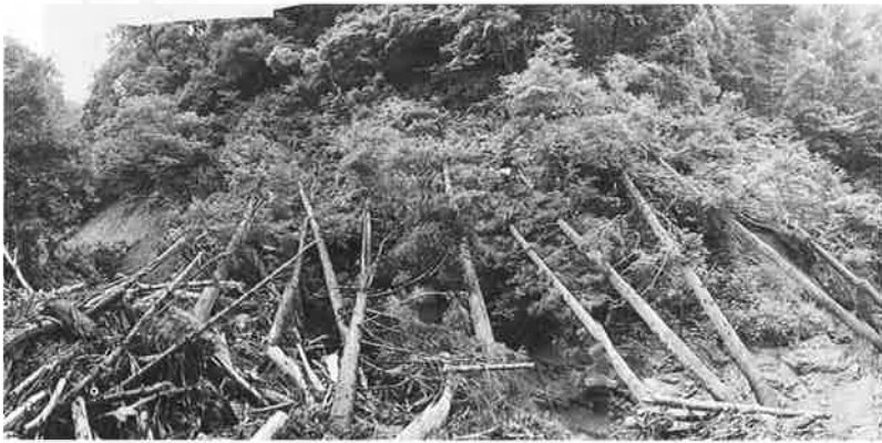
豪雨による溪岸崩壊 (平成26年7月南陽市漆山)
