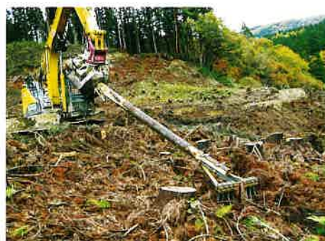
(大型レーキの作業状況)
