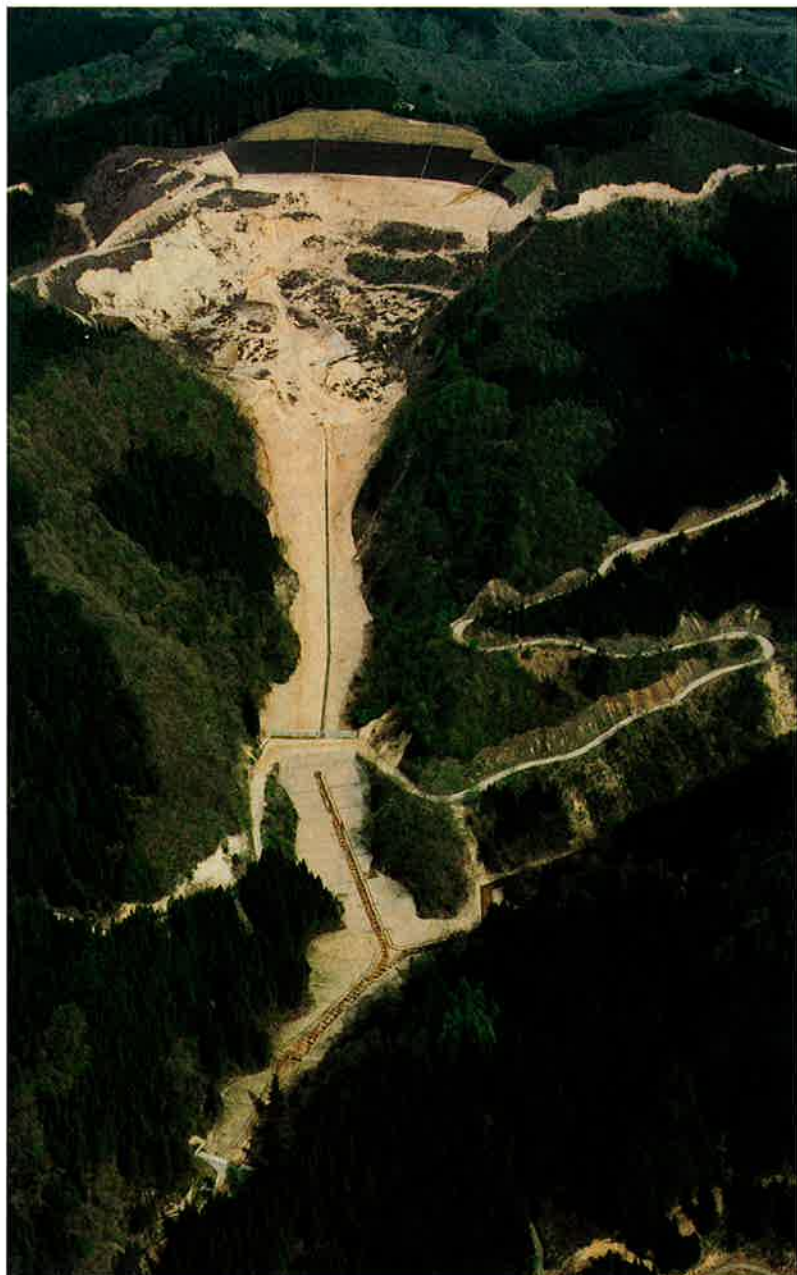
写真左：田代山地区 対策工施工状況（平成14年4月26日）
