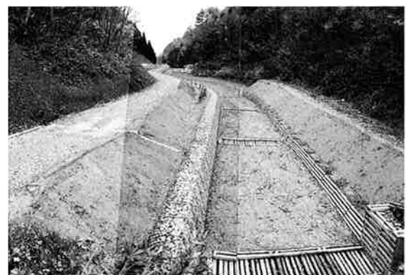
付け替えの完了した林道と溪間工
