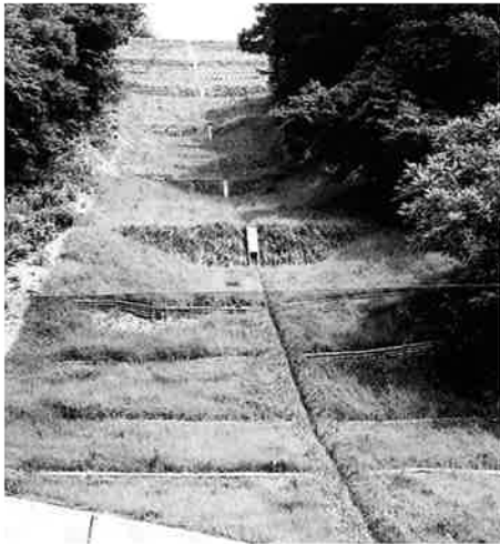
完成した山腹工
