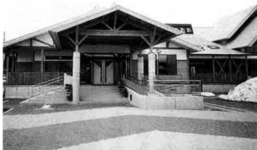
正面から見たわかば保育園（平成13年3月25日完成）
