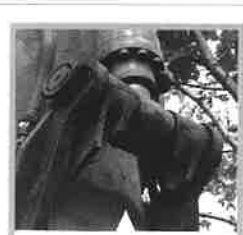
接続ピンの摩擦影響による、リンク周りの破損!
